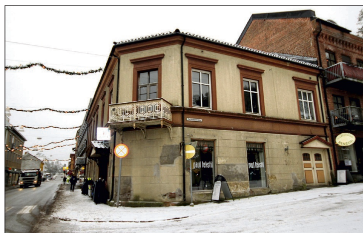
ANSIKTSLØFTING 2: På nyåret skal denne gården pusses opp i forbindelse med ombygging til leiligheter i annen etasje.
