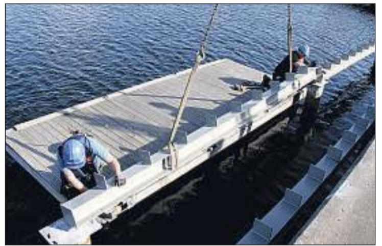
NESTEN SOMMER: - Det beste med denne jobben er akkurat nå været, sier Ingar Norheim liggende over en stålbejelke mens han skrur på plass boltene. Fra en flåte monterer han og kollega Jon Anders Johansen bjelker på løpende bånd.
