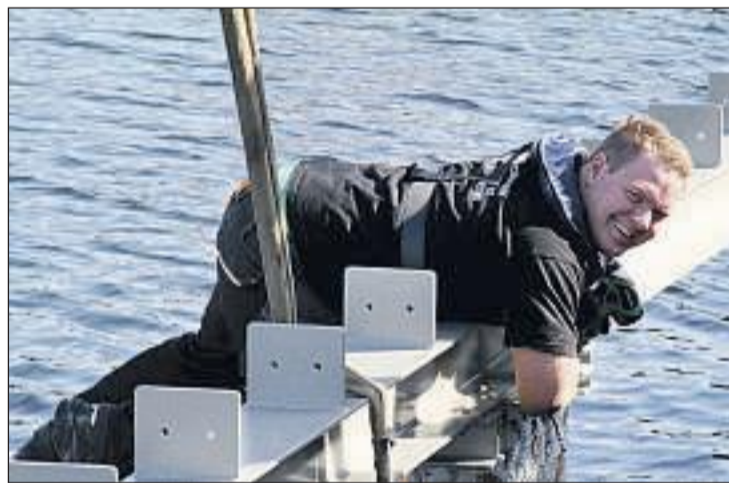
NESTEN SOMMER: - Det beste med denne jobben er akkurat nå været, sier Ingar Norheim liggende over en stålbejelke mens han skrur på plass boltene. Fra en flåte monterer han og kollega Jon Anders Johansen bjelker på løpende bånd.
