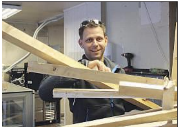
RIVER: Hele disken er revet ned og skal bygges opp på nytt. For at den skal bli mer innbydende for lunsjgjestene.
