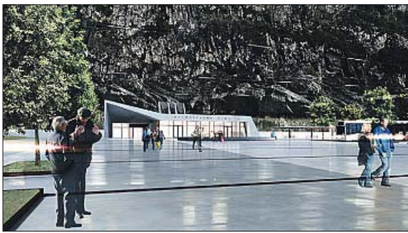
FERDIG HØSTEN 2016: 12,3 kilometer tunnel med dobbeltspor, og verdens største stasjonshall med fire spor, derav to gjennomgående bygget for 250 kilometer i timen. InterCity-strekningen mellom Oslo og Tønsberg skal stå ferdig i 2023. I Holmestrand blir det i tillegg heisforbindelse mellom stasjonen og fjellplatået, ny kollektivterminal og infrastruktur i sentrum. (Skisse: Jernbaneverket)
