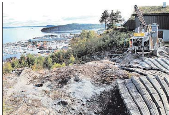
UNDER ARBEID: Sprengningsarbeidet er i gang ved toppen av heissjaket i Roveveien. En heissjakt mellom stasjonshallen og toppen av fjellet som blir cirka 70 meter lang. (Foto: Pål Nordby)
