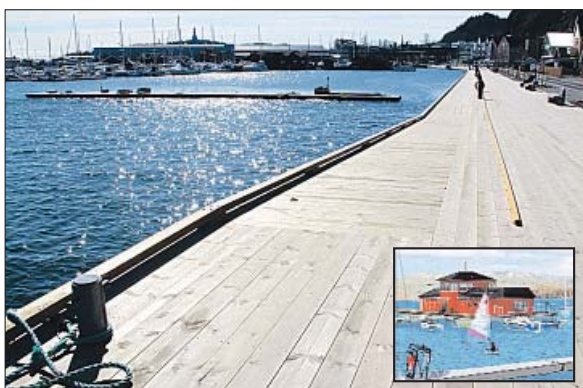
FERDIG I 2012: Havnegaten med ny front og gjestebrygge har gitt sentrum et stort løft for innbyggere og turister. Om to år er planen at båtgestene skal tilbys et servicebygg med fasiliteter. (Foto: Pål Nordby)
