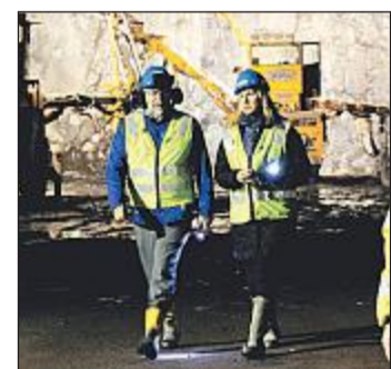
FORNØYD: Prosjektleder Marit Synnes Lindseth gleder seg til ferdig heis i Holmestrand.
