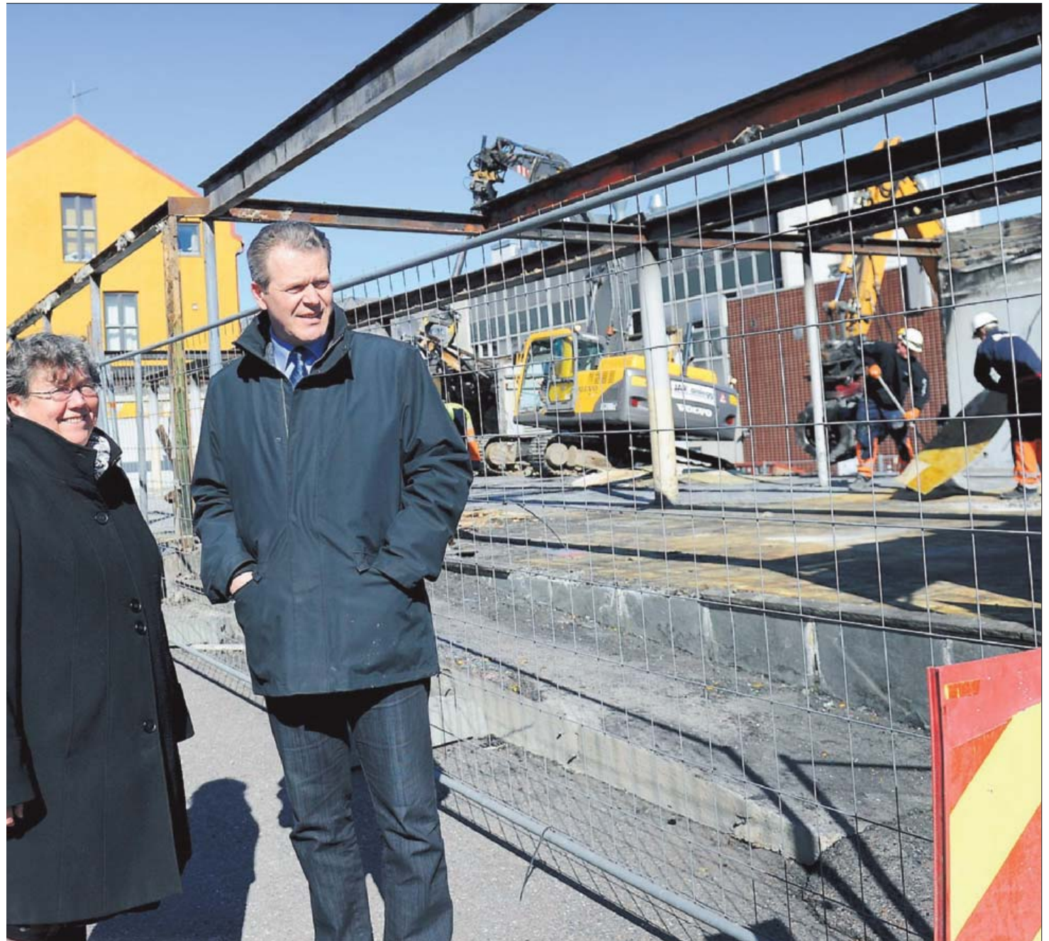
VEKSTBYEN: Både ordfører Alf Johan Svele og kommuneplanlegger Inger Christensen er overbevist om at Holmestrand blir vekstkommunen i Vestfold med de mange prosjekter som skal gjennomføres. Her i Langgata skal store deler av gata glasses inn.
