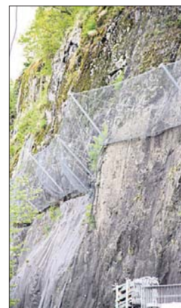
NETT: Fjellet er sikret med fallnett. FOTO: LARS IVAR HORDNES
