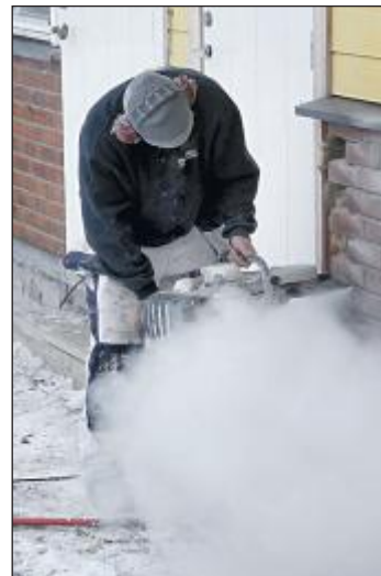
SKJERER BETONG: Lærling Daniel Foss hos Murmester Kongsten gjør forberedelser til ny murstein ved inngangsdøra.
