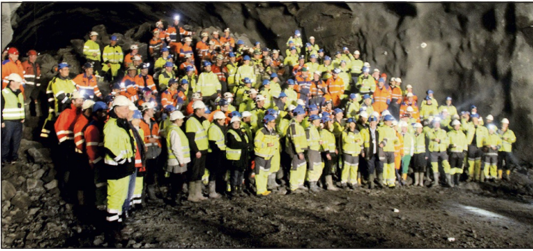
6. MARS: Gjennomslag mellom Stasjonshallen og Sjøskogen markerte åpen tunnel på 12,3 kilometer. FOTO: PÅL NORDBY
