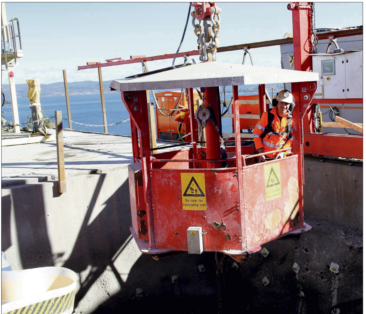
70 METER LANG SJAKT: Her er arbeidet i full gang med å sprengre ut heissjakt fra toppen og nedover.
