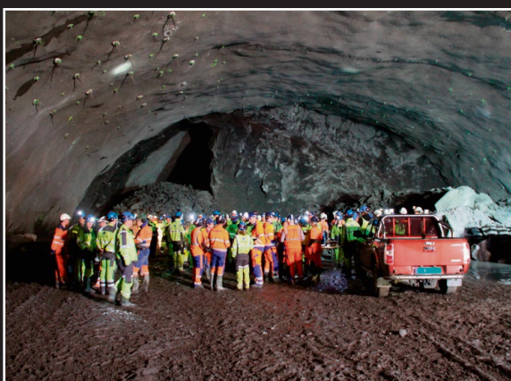
JUNI 2014: Gjennomslag i stasjonshallen. Prosjektleder Morten Klokkeveen og byggeleder Nina Rongved skålte i konjakk på røysa. FOTO: PÅL NORDBY
