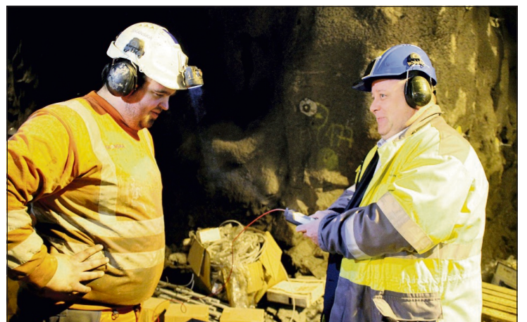
EN MILEPÆL: Gjennomslag mellom Stasjonshallen og Sjøskogen. Statssekretær Bård Hoksrud (FrP) koste seg. FOTO: PÅL NORDBY
