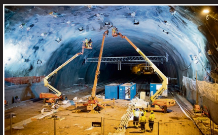
PLATEARBEID: Stål i tunnelen.
