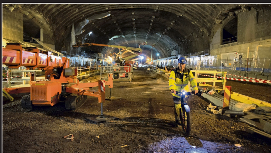
APRIL 2016: Rune «Reodor» Johansen tar seg fram på elektrisk sparkesykkel gjennom hallen, som foreløpig er langt fra å ligne på en jernbanestasjon.
