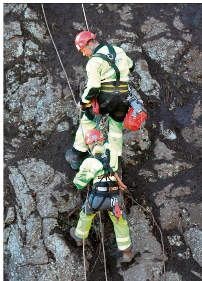
SJEKKER: Anleggsleder Helge Fristad fra AST og sjefsgelog Hanne Sagen Wiig fra Jernbaneverket sikrer fjellet ved Sjøskogen.
