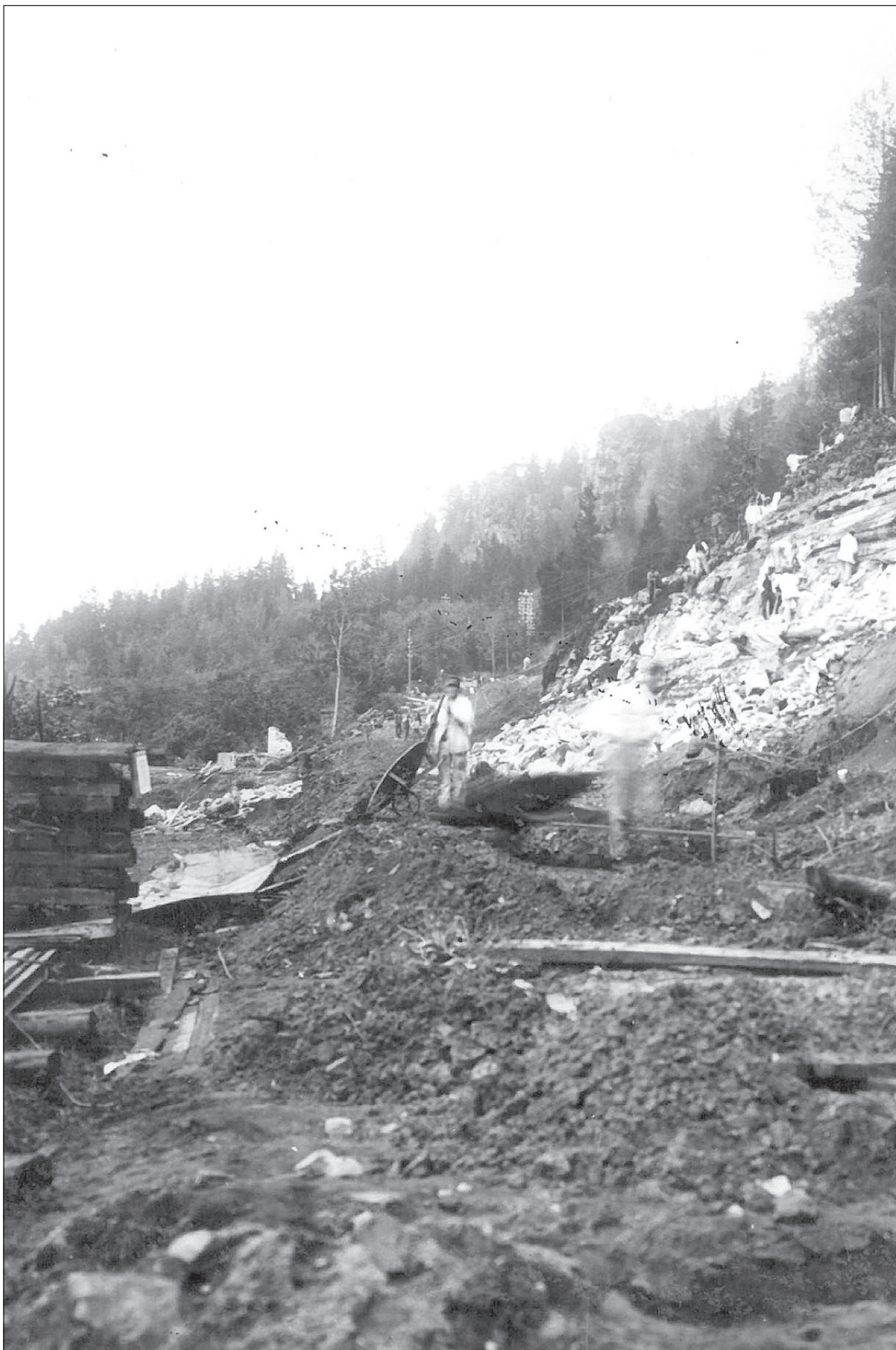
MYE JOBB: Det aller meste måtte gjøres for hånd da utbedringsarbeidet tok til.
