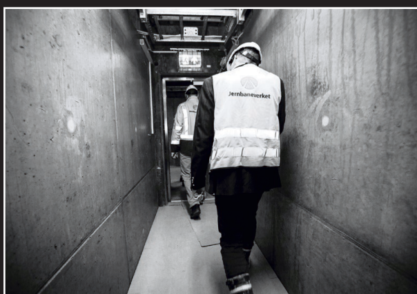
BEFARING: Samferdselsminister Ketil Solvik-Olsen besøkte byggeplassen i september.
