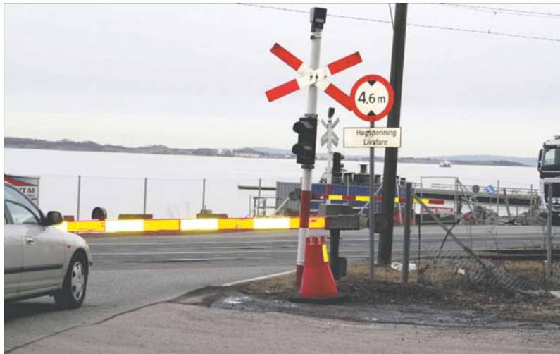
PLANOVERGANGEN: Disse bommene kjøres stadig ned og må repareres, ifølge banesjef Bjørn Ståle Varnes.
