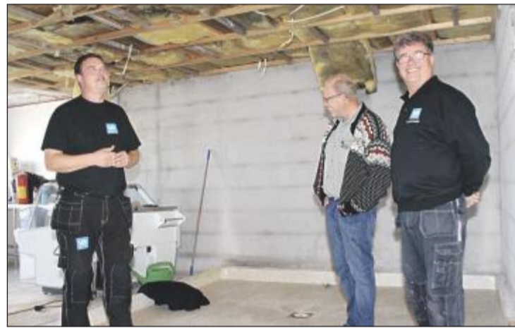
MYE Å TA TAK I: Lokalene trenger sårt til en oppussing, sier daglig leder i Håndtverkern AS, Arild Brekke (t.v.) - og ser mot taket.
