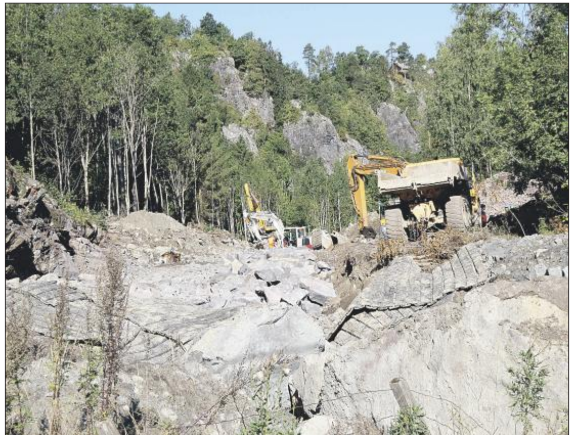
ANLEGGSSVEI: Ved Sjøskogen bryter maskinene seg frem på ny vei. (Foto: Pål Nordby)
