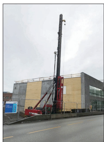
IKKE DEN FØRSTE: Pæling ned til fast fjell må til.
