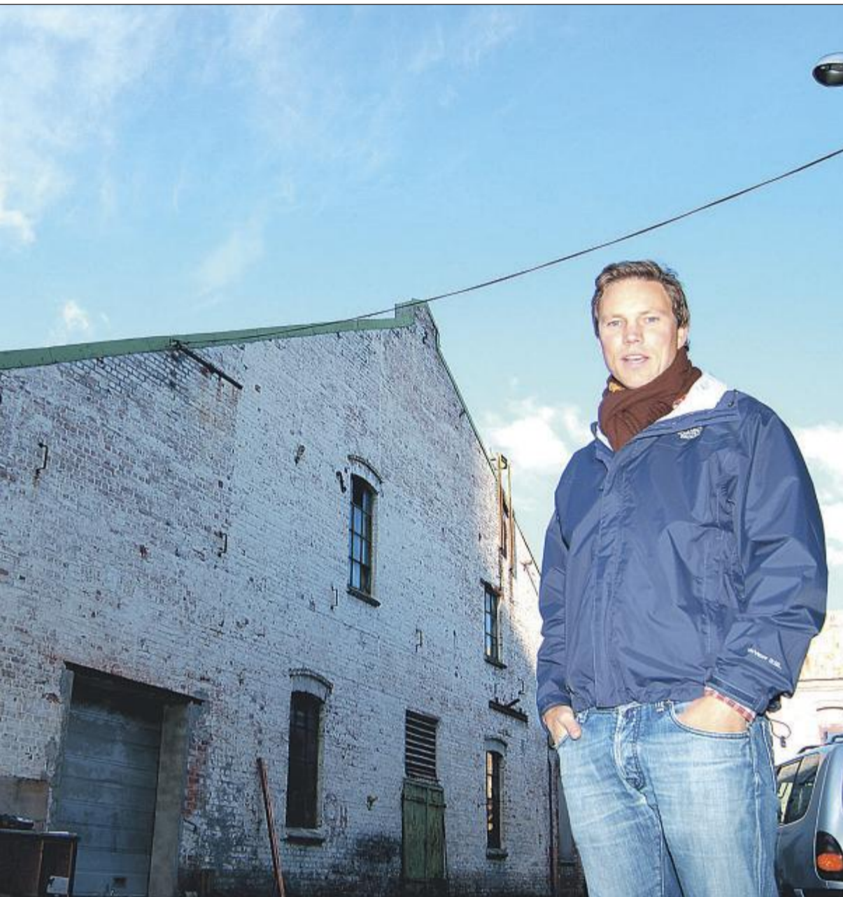
rik Sunde i Hagemann Brygge AS er i gang med å finne entreprenør til å rive den gamle Melkefabrikken i sørbyen. Riktignok sikret del av arbeidet. (Begge foto: Lars Ivar Hordnes)
