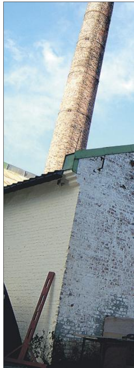
STARTER RIVING SNART: Daglig leder Eirik Sunde mener at riving av den gamle fabrikkpipa blir en særskilt fordel.
