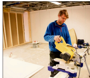
I GANG: Ole Bent Larsen fra Sande er blant snekkerne som nå bygger Holmestrand nye servicesenter.
