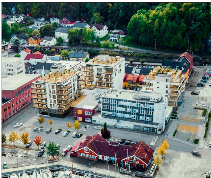
BYGGESTART: Byggingen av blokka ut mot Langgaten skal starte denne uka. Blokka på hjørnetomta har byggestart i juni.
